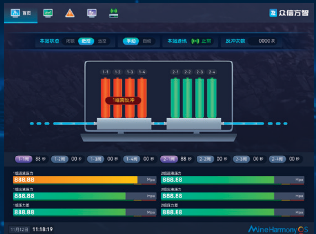
反冲过滤分站
